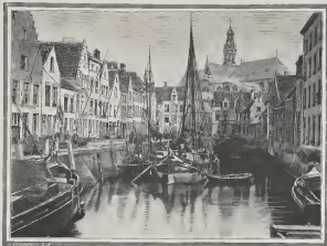
Canal à Charleroi, exécuté lors de la rectification des quais.
